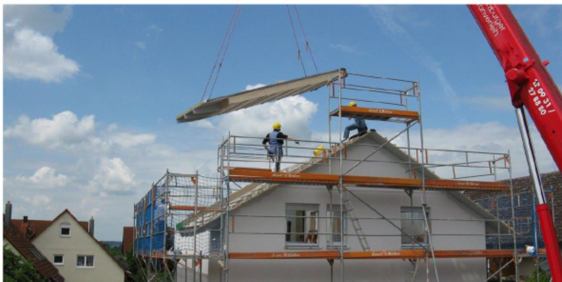
Lavori in corso per il Superbonus
